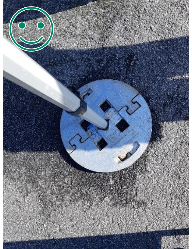
Kuva 4 HYVÄ TAPA. Kaksi kerrosta painoja vastasuuntaisesti. Lukitsevat kerrokset tolpan ympärille, kun tolpan aluslevy on riittävän kokoinen ja kiinteä. Kulmatolpan maajalan tulee kestää kyseinen paino.
