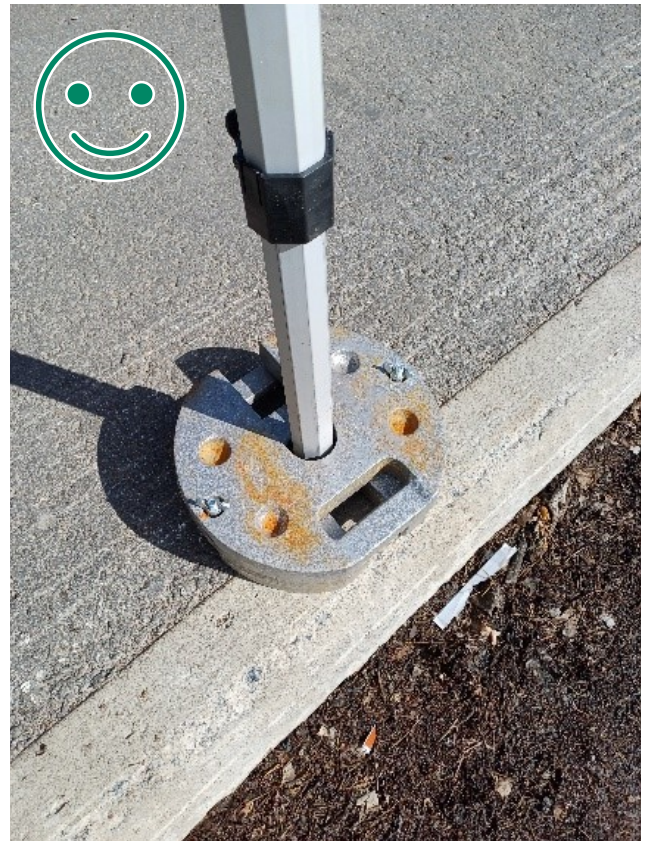
Kuva 2 HYVÄ TAPA. Molemmat painot kiinnitetty siipimutterilla molemmin puolin. Hevosenkäpypainot vastakkain, jolloin tolppa ei pääse irtoamaan rakenteen liikkeessä. Kulmatolpan maajalan tulee kestää kyseinen paino.
