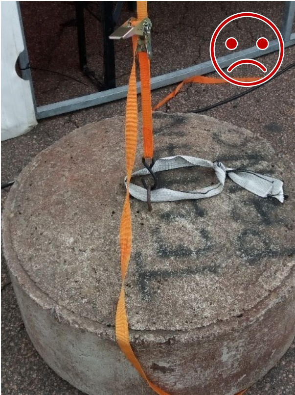
Kuva 7 EI NÄIN. S-koukku ei ole lukittava. Koukku irttaa rakenteen liikkuess.
